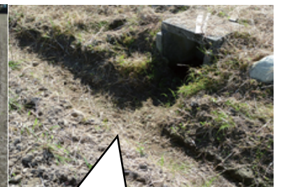
額縁排水溝を水尻に連結
